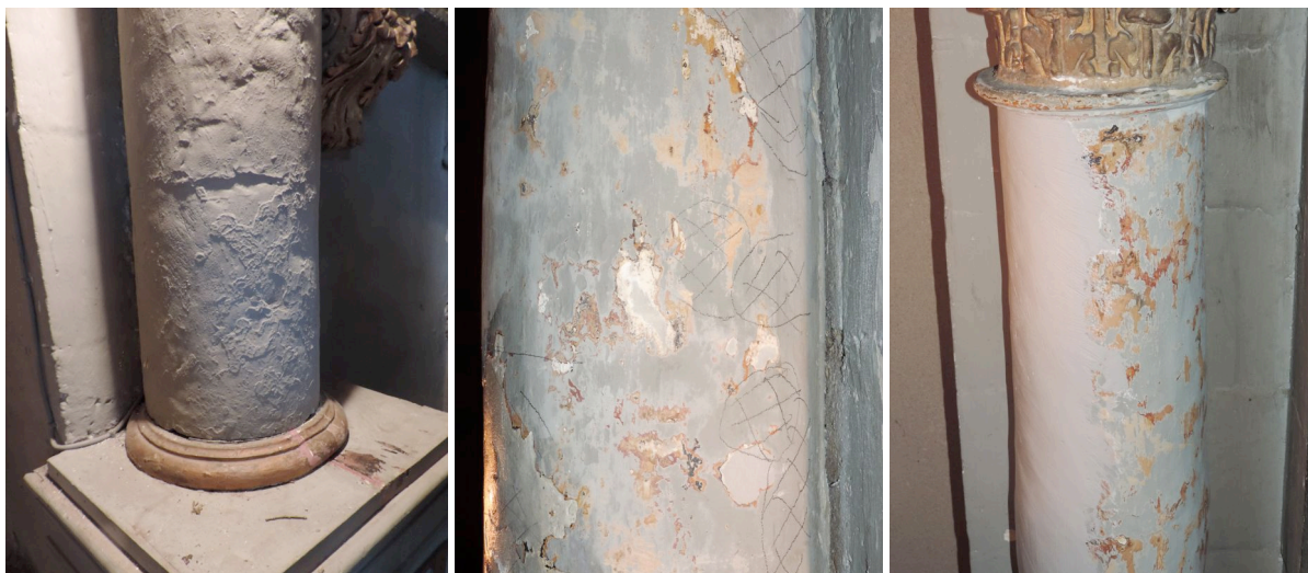
Mise en évidence et repérage des dépressions, préparation de la surface et application d'un enduit gris clair
